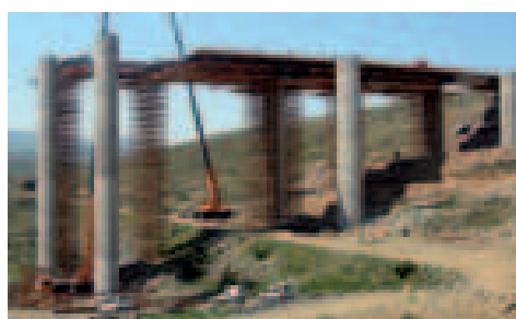
Viaducto de Ágreda, Soria, España
