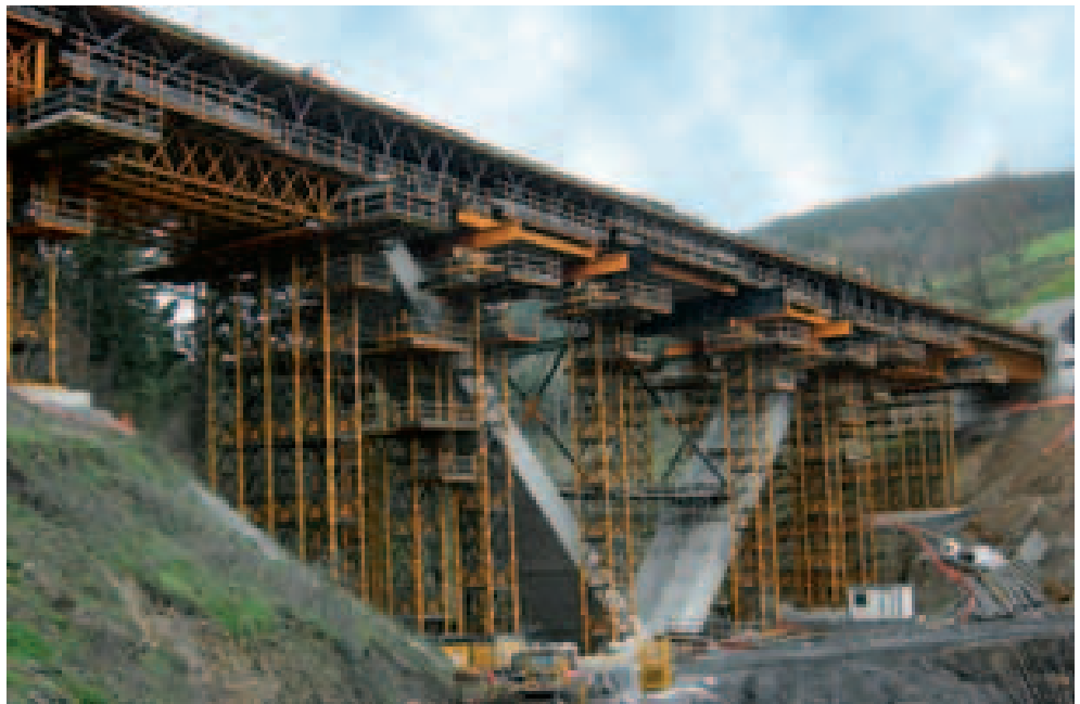
Estructura H-33 en el Viaducto de Basagoiti, Aretxabaleta, España
