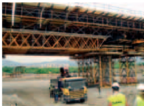
Viaducto en Santa Coloma de de Cervelló, Barcelona, España
